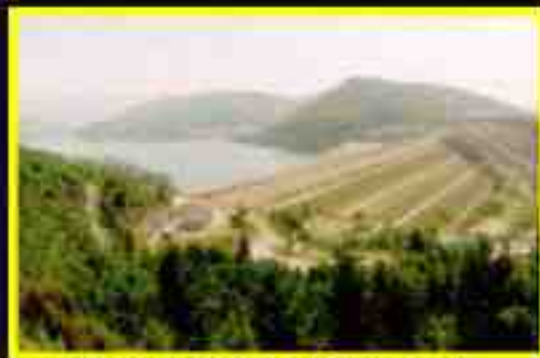
Diga di Montedoglio sul F. Tevere
