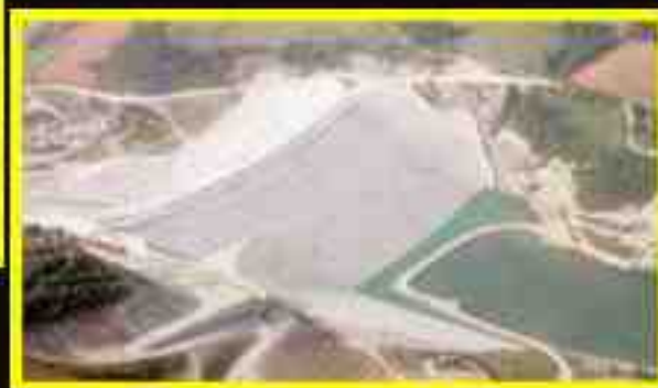
Diga Casanuova sul F. Chiascio 25 \cdot 10^6 \text{ m}^3 volume laminazione 181 \cdot 10^6 \text{ m}^3 volume totale
